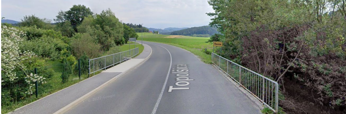
Slika 2: pogled na obstoječi premostitveni objekt v smeri stacionaže
