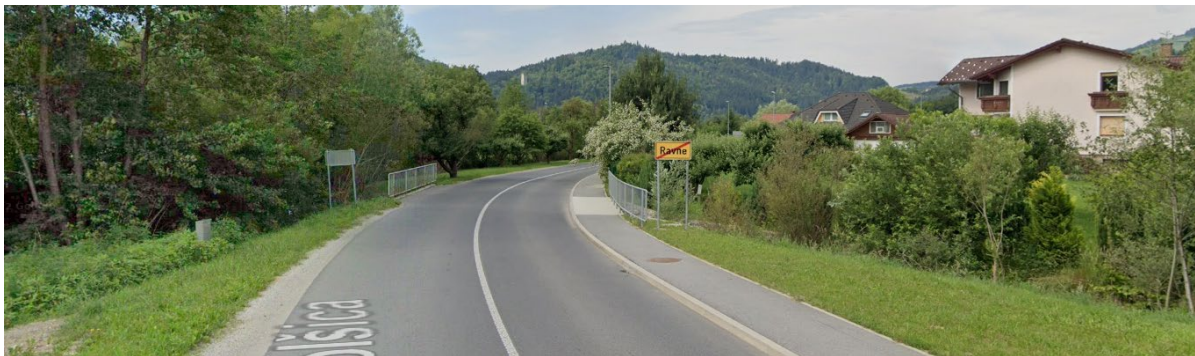
Slika 3: pogled na obstoječi premostitveni objekt v nasprotni smeri stacionaže
